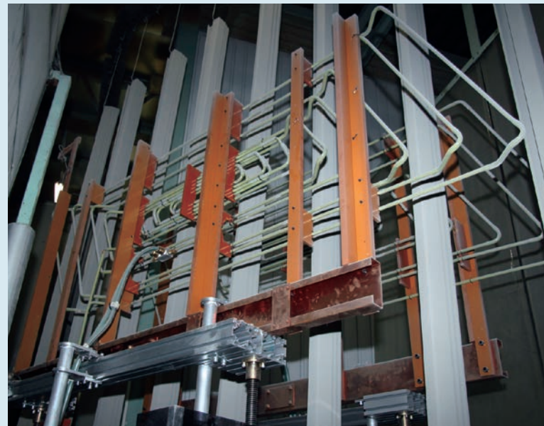
▲ 焼き付け乾燥の前に予備加熱を行うIH式誘導加熱装置
